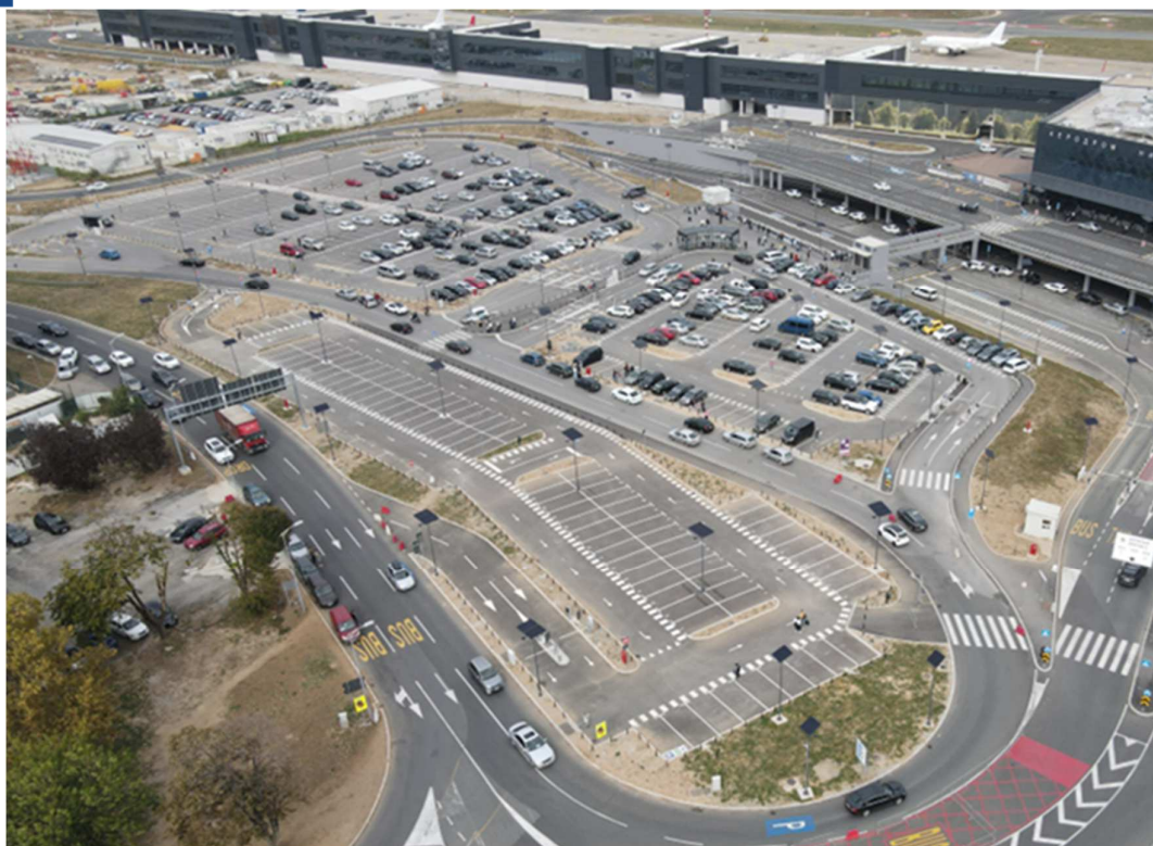
Слика 4 Паркинг испред терминалне зграде - Контакт паркинг
